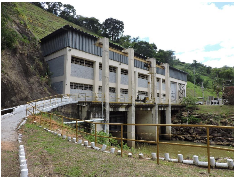
Figura 2 – Casa de Força da PCH João Camilo Pena
